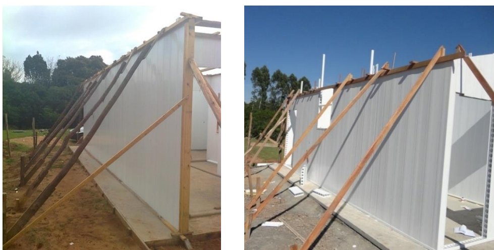
Exemplo de escoramento paredes
