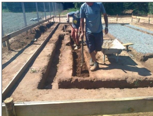
03- Gabarito e escavação.
