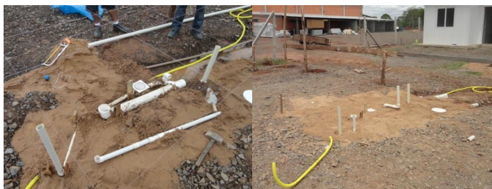
Exemplo de espera de esgoto e entrada de água no radier/base de concreto antes da concretagem
