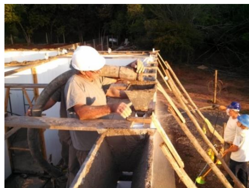
Concretagem com bomba e calha funil
