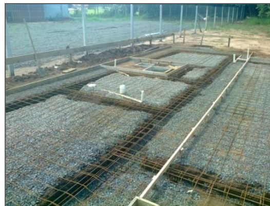
04 - Instalações de esgoto e água, entrada de energia (quando for o caso), lastro de brita e armaduras.
