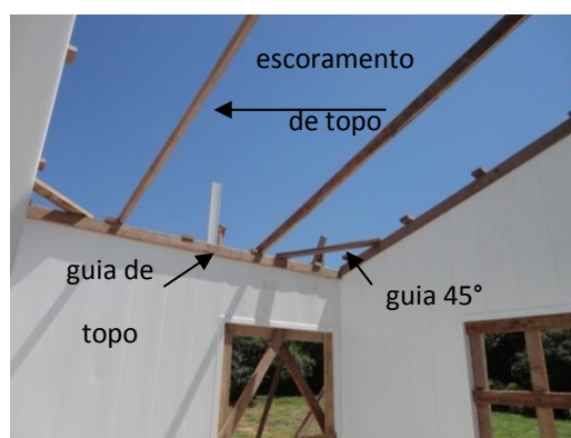
Exemplo de escoramento de topo
