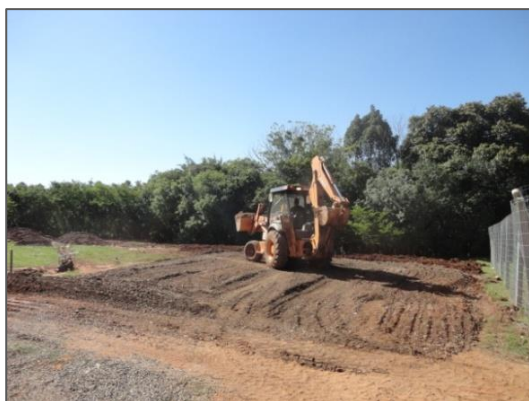
01 - Terraplanagem e movimento de solo.
