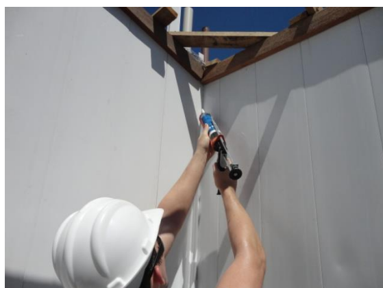
Aplicação de PU no encontro de paredes perpendiculares
