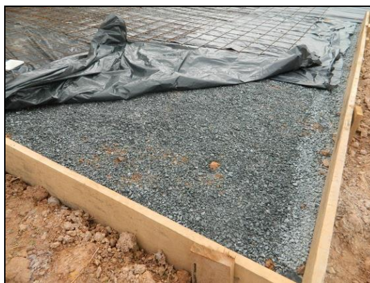
Exemplo de montagem radier pré concretagem
