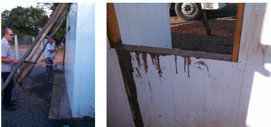
Limpeza dos painéis após concretagem
