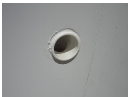
Vedação com PU monocomponente
