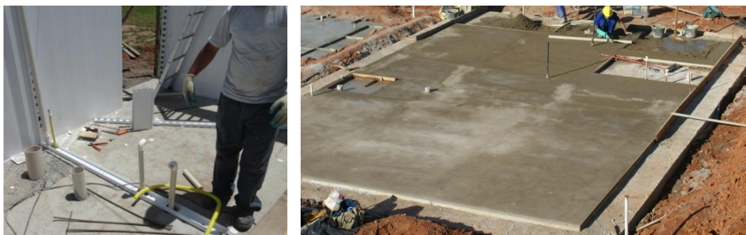
Exemplo de espera de esgoto e entrada de água no radier
