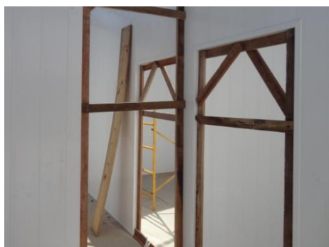
Exemplo de escoramento vão de porta
