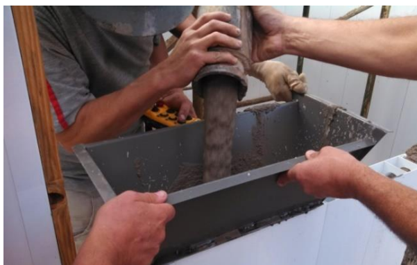
Concretagem com bomba e calha funil
