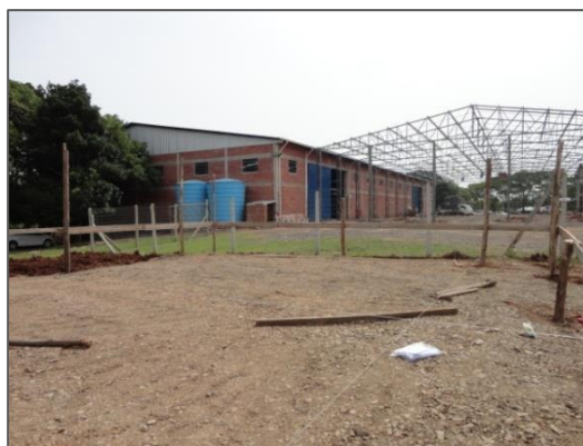
02 - Compactação e nivelamento do lote.
