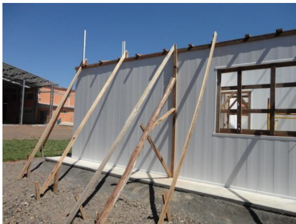
Exemplo de escoramento encontro de paredes
