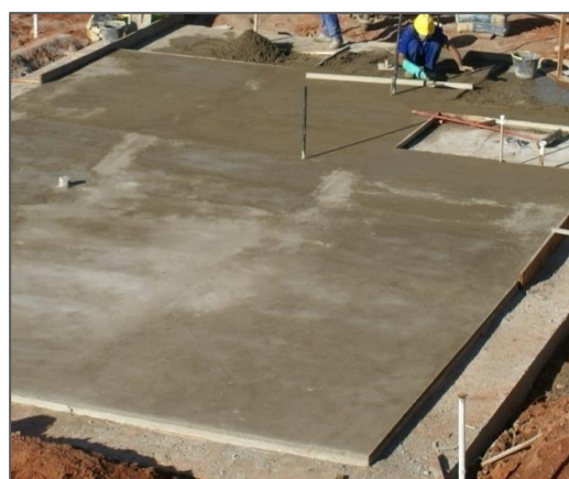
06 - Regularização do radier
