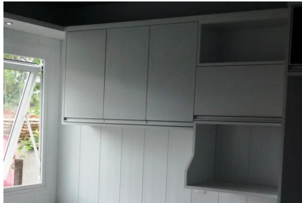
Armários suspensos fixados com bucha e parafuso
